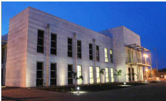
Imagen del nuevo edificio de la Embajada de España en Malabo, inaugurado en julio de 2011. © EFE
